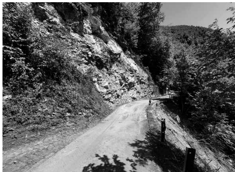
TAKO KOT SO NA TEJ OBČINSKI CESTI ZAHTEVNE VSE NALOŽBE je ogromno natančnosti in previdnosti terjala tudi interventna faza sanacije skalnega podora pred vasjo Čadrg, v kateri je bilo treba iznad cestišča odstraniti skoraj 250 m 3 materiala. Foto: Boštjan Uršič
